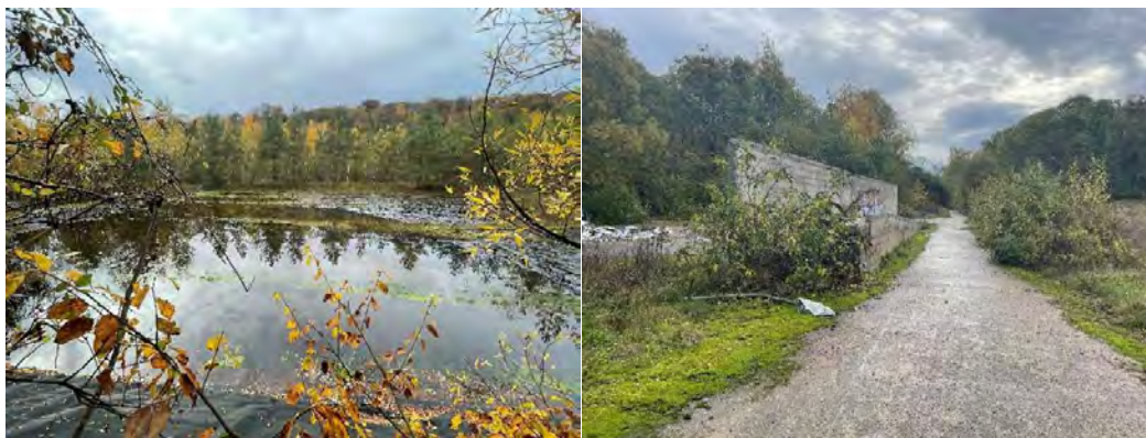
A gauche : bassin artificiel réalisé dans le cadre du projet de centre d'enfouissement – à droite : voie d'accès et quai de déchargement.
