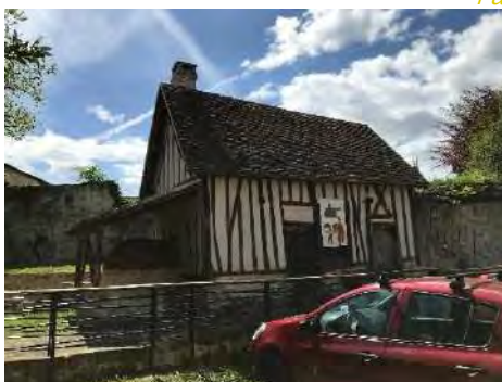
Figure 249 - Four à pain à Pont-de-l'Arche (source : CAPLA Architecture)
