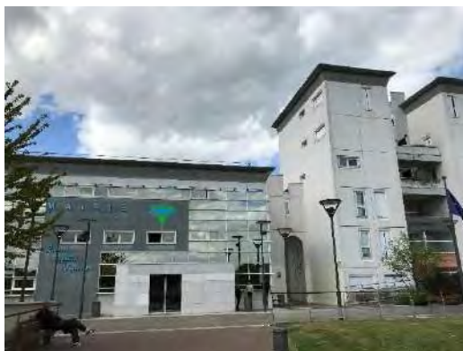
Figure 223 – Centre-ville du Vaudreuil
