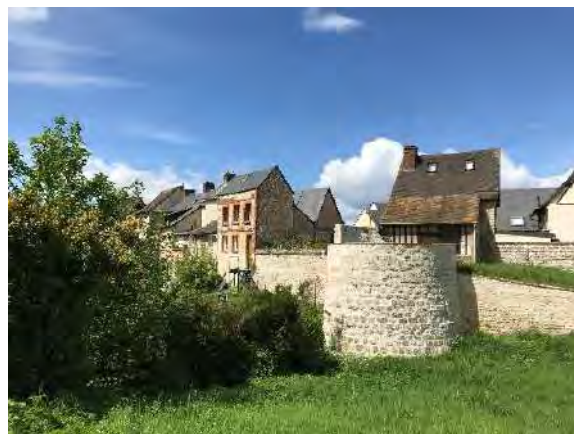
Figure 230 – Enceinte urbaine à Pont de l'Arche
