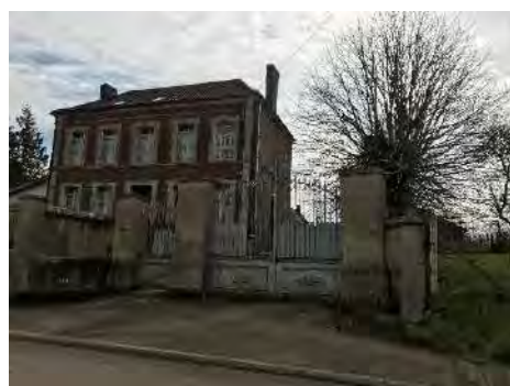
Figure 241 - Maison de Maîtres à Vraiville
