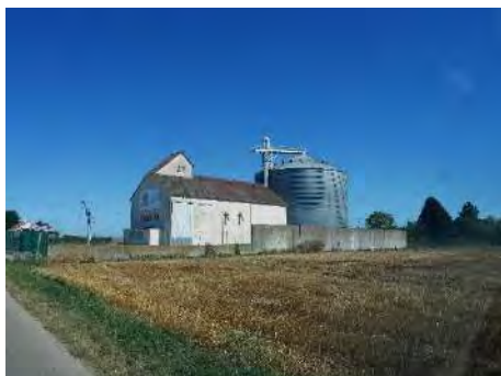
Figure 26 - Silo sur le plateau de Madrie, Les Rondeaux
