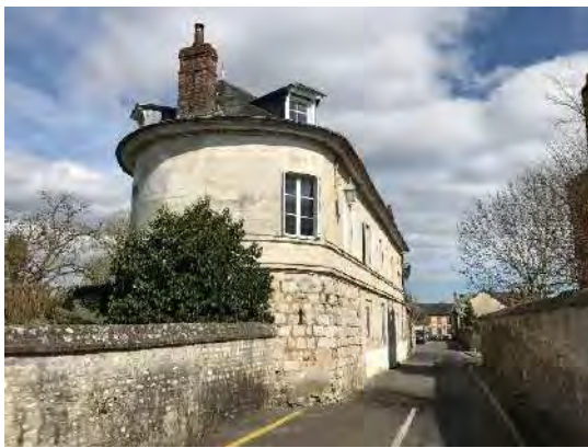
Figure 229 – Propriété de la Tour de Crosne à Pont de l'Arche
