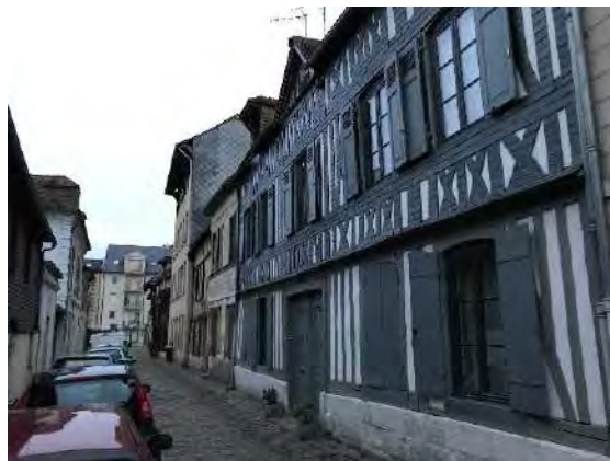
Figure 216 – Centre-ville de Louviers
