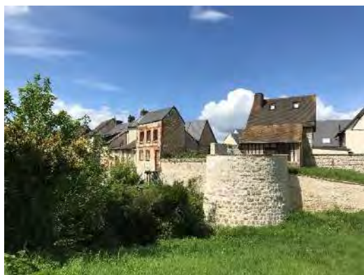
Figure 200 – Enceinte urbaine à Pont de l'Arche
