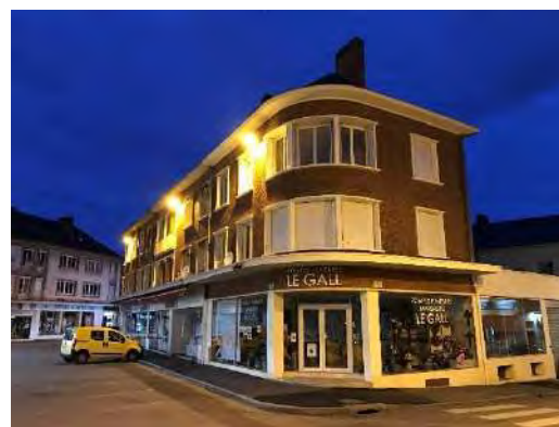
Figure 222 – Centre-ville de Louviers
