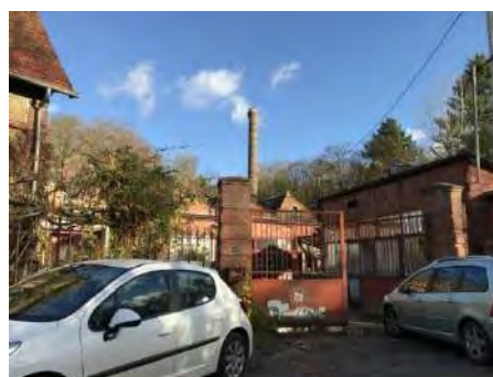
Figure 242 – Usine à Amfreville-sur-Iton
