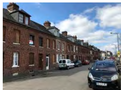
Figure 234 – Habitations groupées ouvrières à Pont de l'Arche
