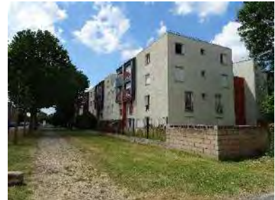
Figure 20 / Logements collectifs à Val-de-Reuil (Source : Geostudio)
