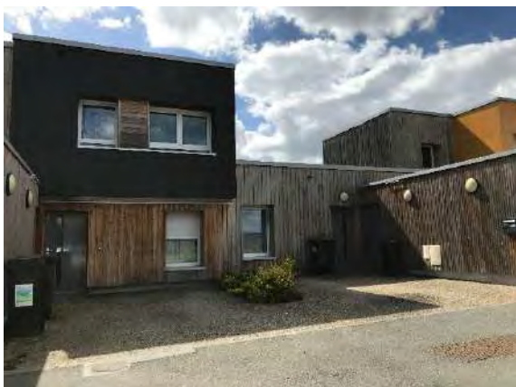
Figure 18 : Logements groupés contemporains à Val-de-Reuil
