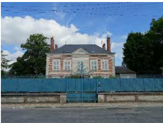
Figure 7 : Maison remarquable à Acquigny (Source : Geostudio)
