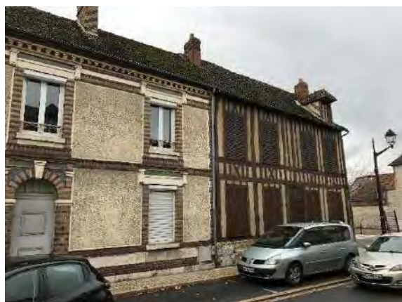
Figure 11 : Maison de bourg au Vaudreuil
