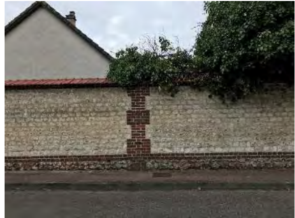
Figure 17 : Clôture pleine maçonnée à Alizay
