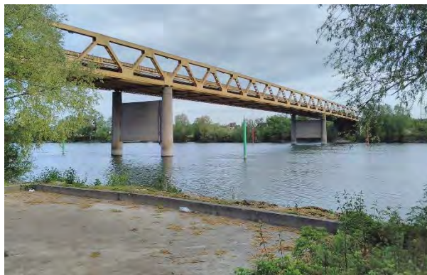
Figure 53 : le pont Aubevoye-Courcelles
