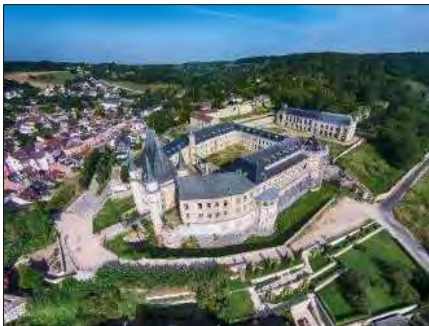
Vue du Château de Gaillon
