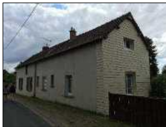
Enduit et bardage inadapté à Saint Julien-de-la-Liègue
