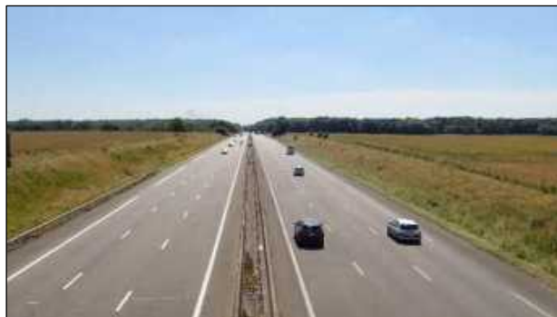
L'autoroute A13 traversant la CCEMS (source : Géostudio)
