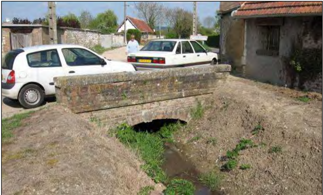
Figure 1 : Pont arche du VC15
