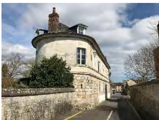
Figure 229 – Propriété de la Tour de Crosne à Pont de l'Arche
