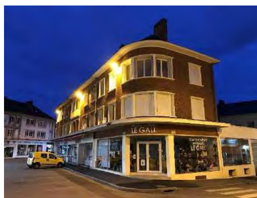
Figure 222 – Centre-ville de Louviers
