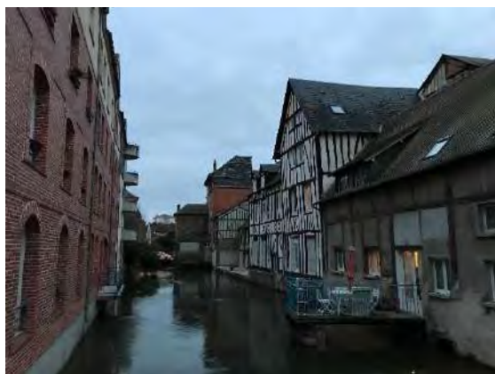
Figure 215 – Centre-ville de Louviers - canaux
