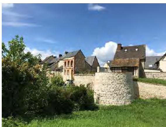
Figure 230 – Enceinte urbaine à Pont de l'Arche
