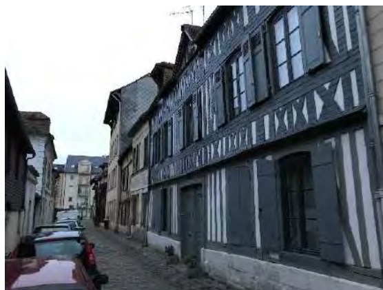
Figure 216 – Centre-ville de Louviers
