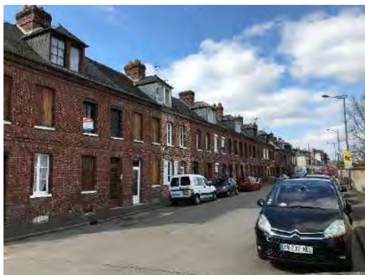
Figure 207 – maisons ouvrières à Pont-de-l'Arche
