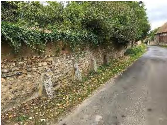
Figure 26 : Mur de clôture en Bauge et pierres au Mesnil-Jourdain
