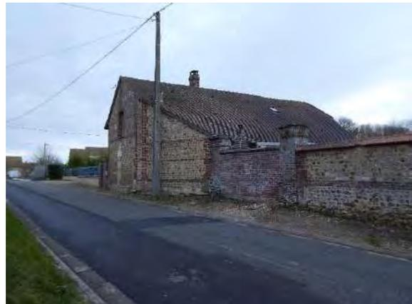
Figure 25 : Mur de clôture maçonné en brique et moellons à Terres-de-Bord
