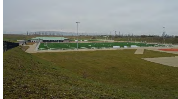
Figure 11 : Complexe sportif au sud du site projet.
