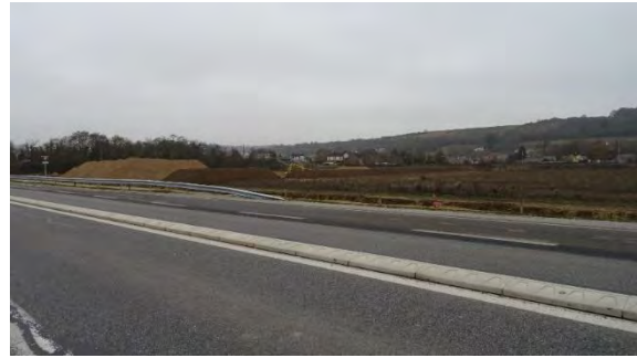
Figure 10 : Travaux d'aménagement en cours vus depuis la RD 321.
