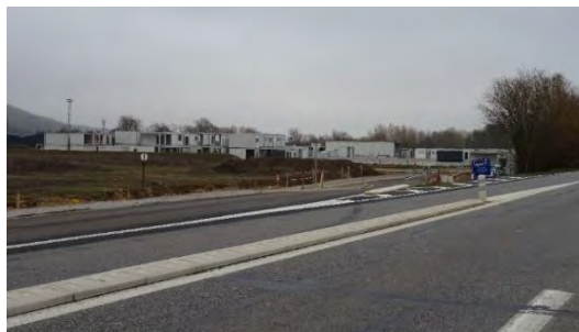
Figure 7 : Sortie de site vers le giratoire en direction de la RD 6015.
