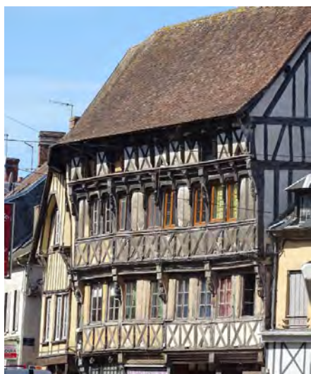
Maison à pans de bois à Gaillon
