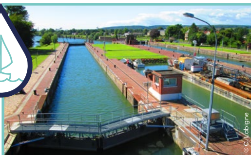
Les écluses d'Amfreville-sous-les-Monts
