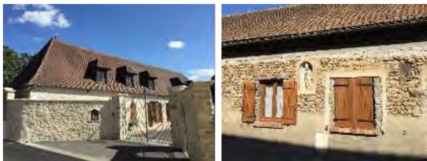
Courcelles-sur-Seine (à gauche) / Champenard (à droite) (source : CAPLA Architecture
