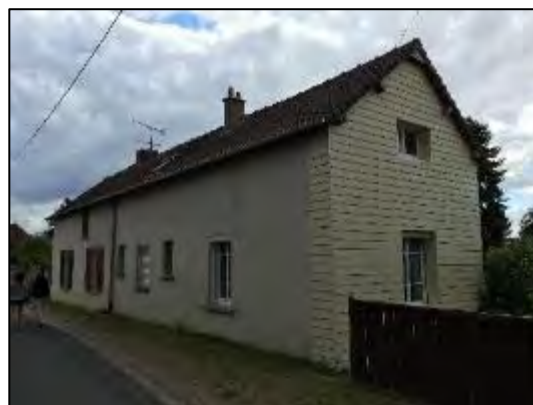
Enduit et bardage inadapté à Saint Julien-de-la-Liègue
