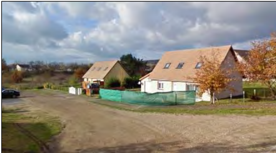
Constructions récentes en lisière urbaine peu intégrée à Bernières
