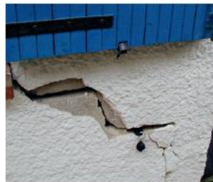
Maison fissurée dans le Pas-de-Calais, août 2009. Sources : BRGM - P. Barin
