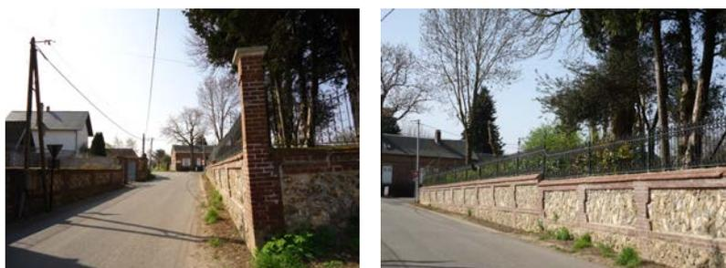
Mur en appareillage constitué de pierres et silex avec une structure en brique en pleine pour consolidation
