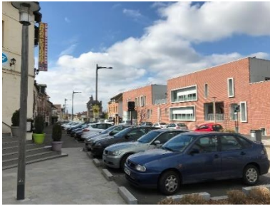
Figure 27 : EHPAD à Pont-de-l'Arche
