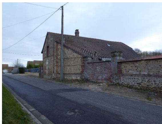
Figure 24 : Mur de clôture maçonné en brique et moellons à Terres-de-Bord
