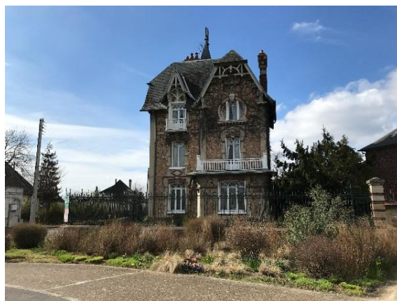
Figure 7 : Maison remarquable à Pont-de-l'Arche
