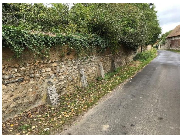
Figure 25 : Mur de clôture en Bauge et pierres au Mesnil-Jourdain
