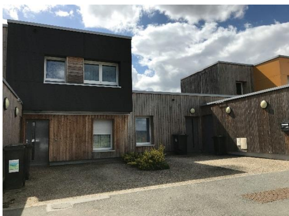
Figure 17 : Logements groupés contemporains à Val-de-Reuil
