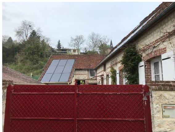
Figure 12 : Panneaux solaires à Andé
